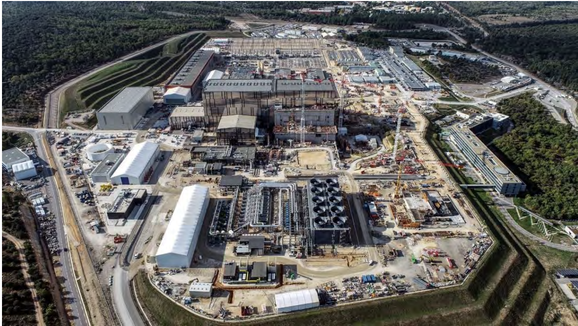
ITER complex ITER bouwen oktober 2021
